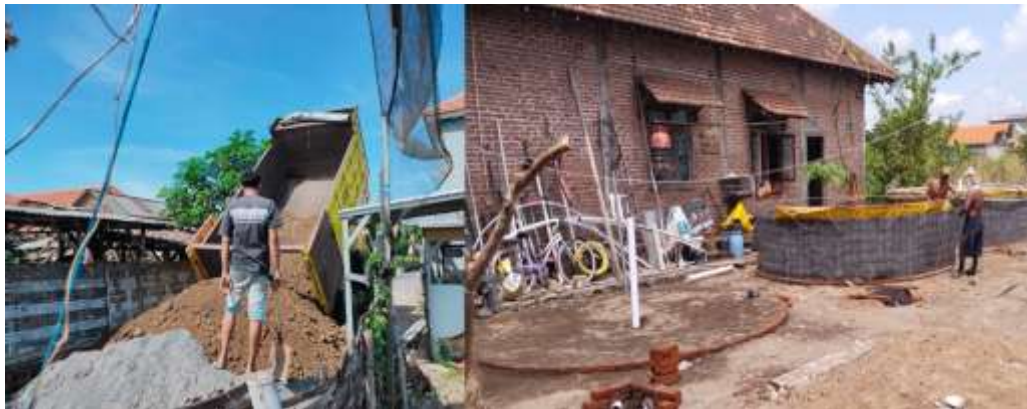
Gambar 3. Penambahan ketinggian dan pembuatan fondasi kolam bundar
