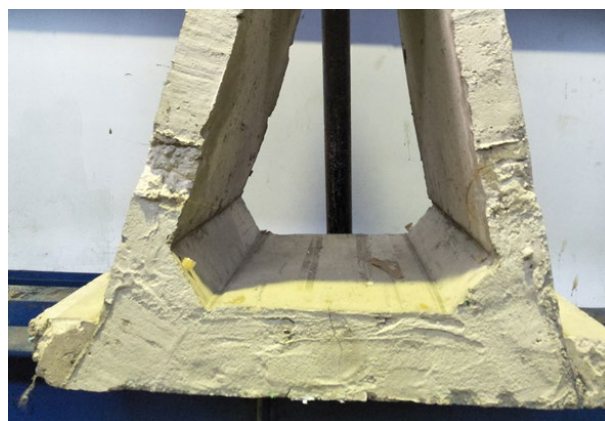
Gambar 6 : Retak pada fondasi pracetak
